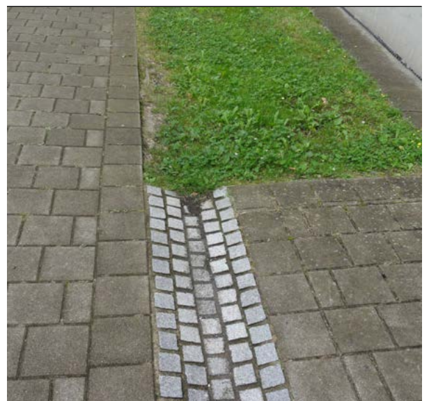
Einfache Maßnahme zur schadlosen Ableitung von Regenwasser
