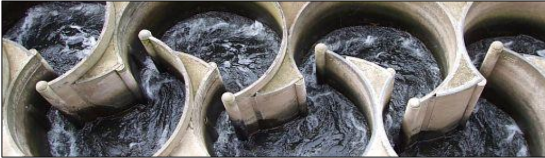
Der Fischpass an der Pfortmühle - wegen des mäandernden Wasserlaufs auch Mäanderfischpass genannt
