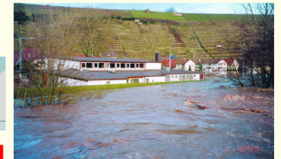
Überströmter Deich in Roßwag an der Enz
