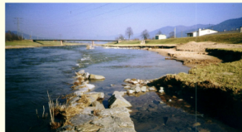
Erosion des Vorlandes an der Kinzig
